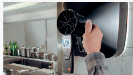
Kontrolle der Abluft an einem Aufputzlüfter
