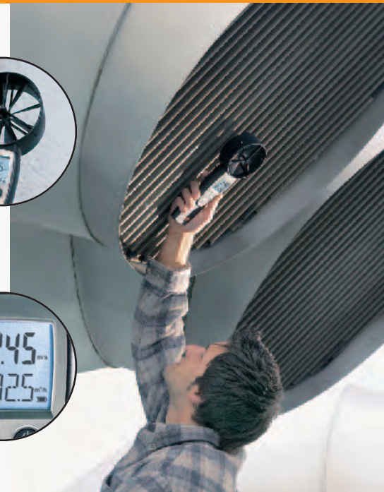
Volumenstrommessung mit großem Flügelrad Ø 100 mm am Kanalauslass
